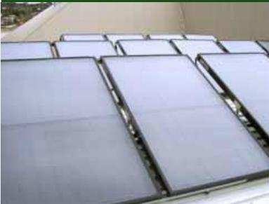
Otra opción sería la utilización de colectores precargados con Glicol Polipropileno, en lo que es este químico el que recibe la energía solar y la transfiere a otro, que podría ser agua o aceite y lo calienta hasta una temperatura prefijada.
